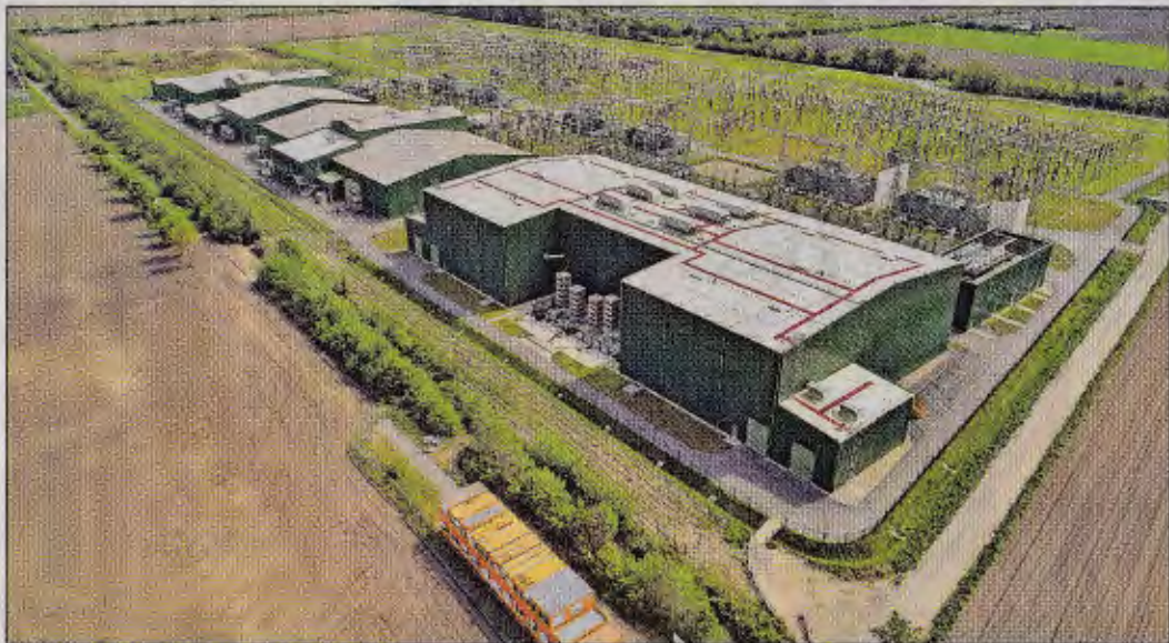
Umspannwerk in Dörpen: Ein Standort benötigt bis zu 25 Hektar Fläche.
