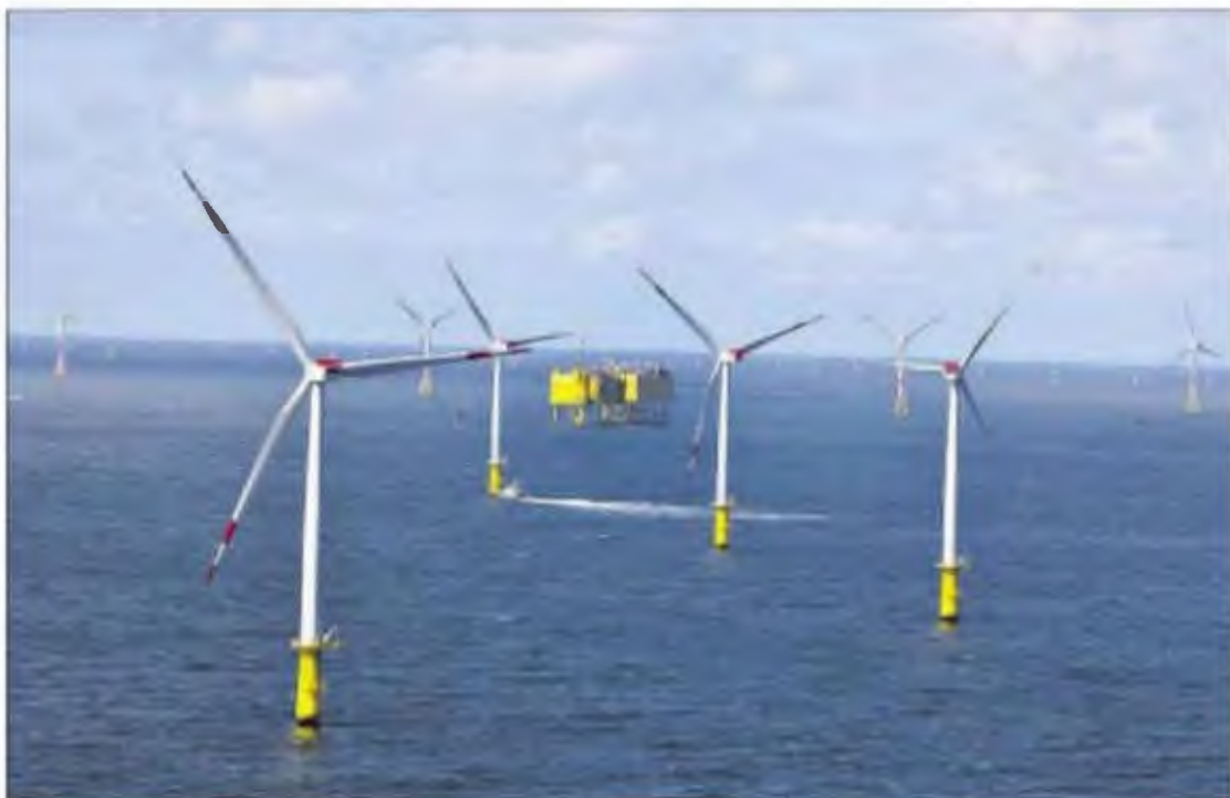
Für mehr Windenergieanlagen spricht sich der Netzbetreiber Tennet aus (im Bild Windräder um die Konverterplattformen „HelWin alpha“ und „HelWin beta“ nahe Helgoland). BILD: TENNET
