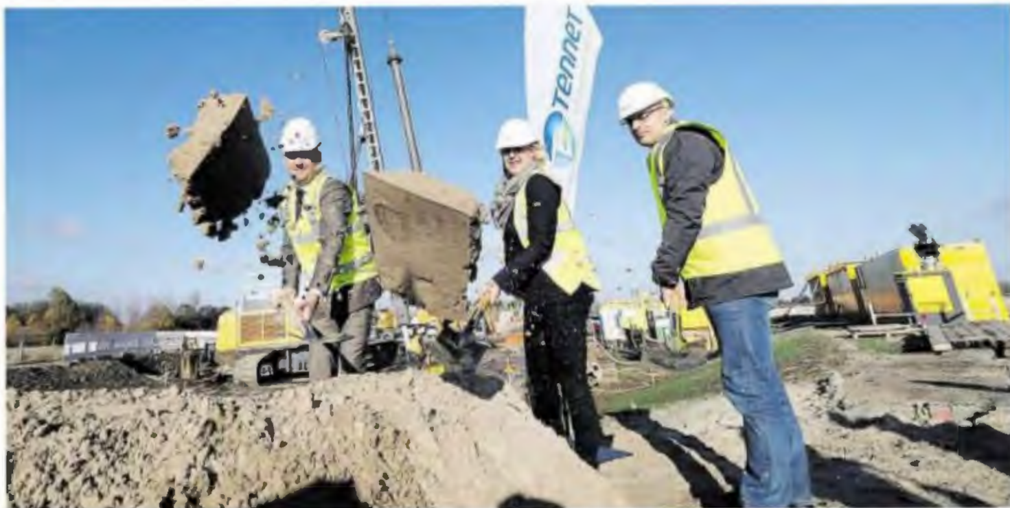
Setzen den symbolischen ersten Spatenstich in Fedderwarden: (von links) Wilhelmshavens Oberbürgermeister Andreas Wagner, Projektleiterin Maren Bergmann und Rolf Neuhaus vom Landkreis Friesland
