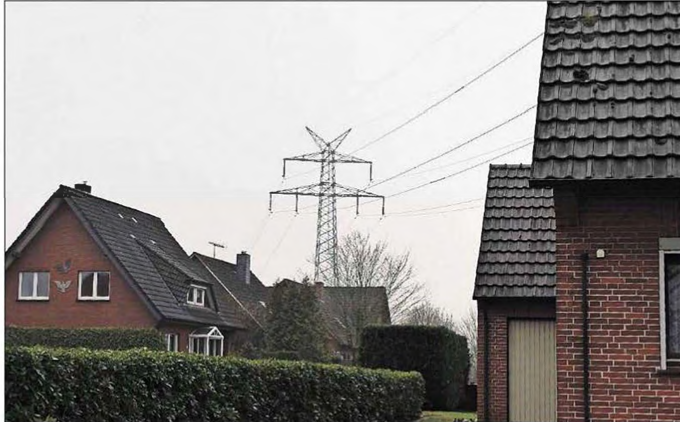
In der Nähe von Häusern: Die Leitung soll im Zuge der neu geplanten Stromtrasse demontiert werden.
