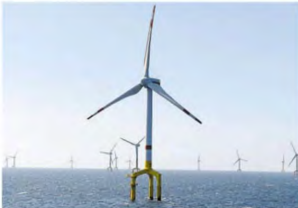
Windräder in der Nordsee – hier vor Borkum. Der auf See produzierte Strom muss in den Süden transportiert werden. Dazu werden Erdkabel verlegt.
