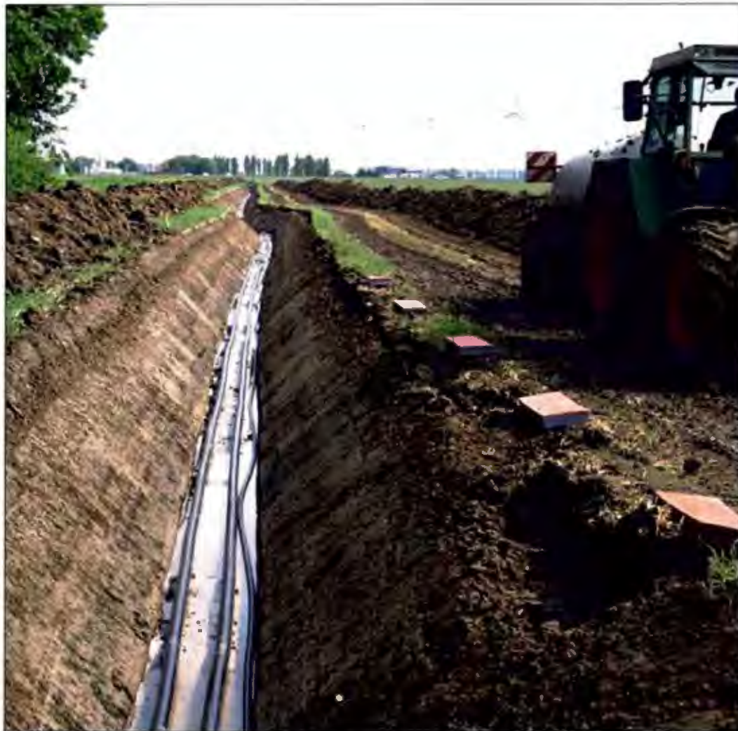
Erdkabel: So wie hier im Landkreis Leer soll die Leitung für Gleichstrom auch im Cloppenburger Nordkreis verlegt werden. Foto: Amt für regionale Landesentwicklung Weser Ems
